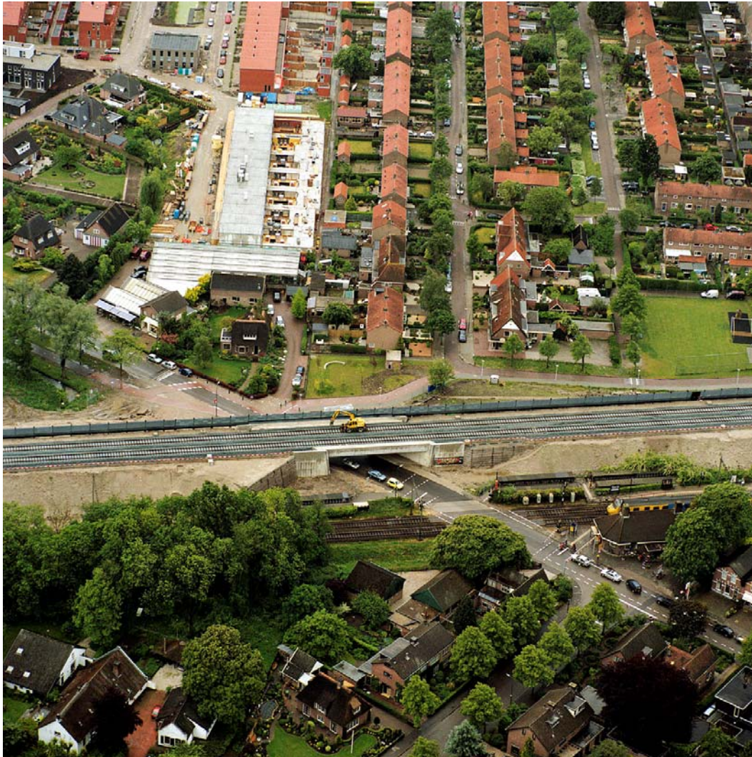
Onderdoorgang Wilhelminalaan project Vleuten – Amsterdam Rijnkanaal
